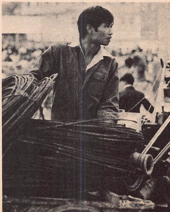
卖了农副产品，买回钢筋建新楼。
